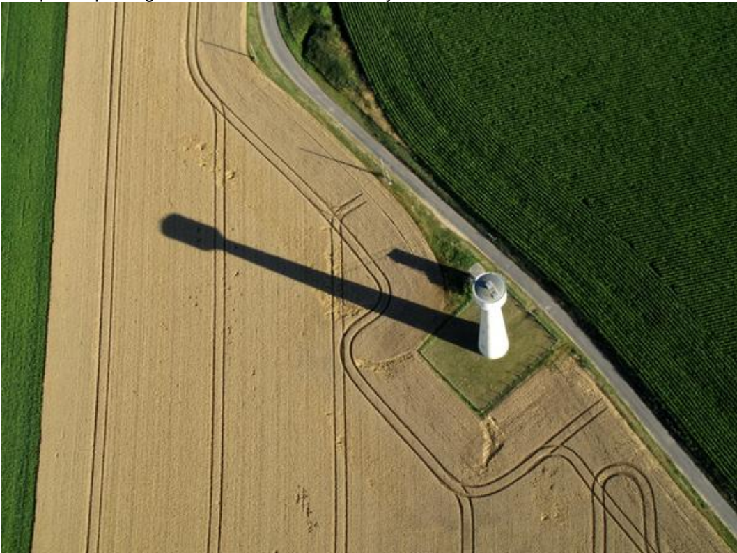
Marque de passage : le château d'eau du Belay
