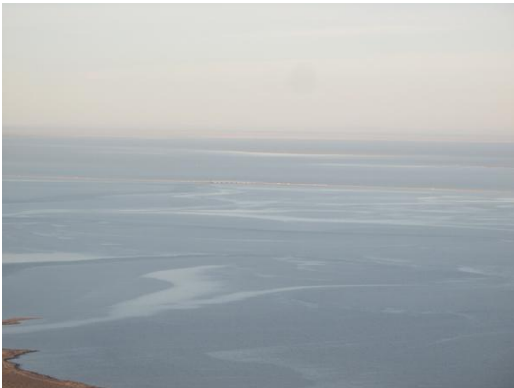
Le pont sur la voie romaine se détache
