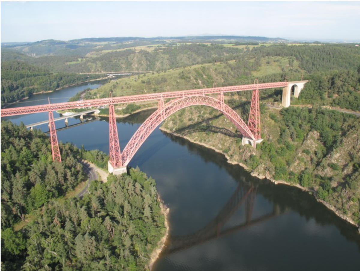
Le viaduc du Garabit
